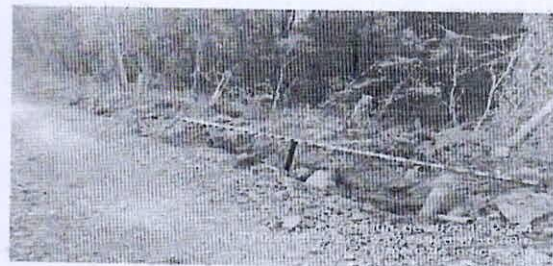
02 Foto.(Proteção de Tubo Superficial)
