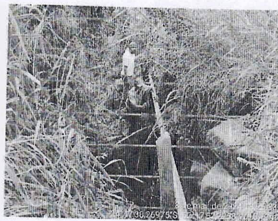
04 Foto Local 3 Vazamento.
