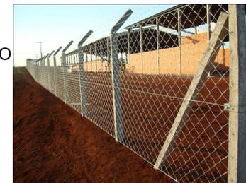
IMAGEM DE REFÊRENCIA - ALAMBRADO C/ POSTE DE CONCRETO ARMADO
