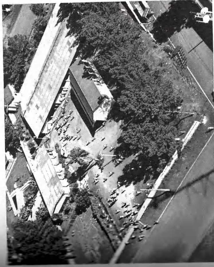
Vista aérea do Colégio Estadual Dr. João Ferreira Neves — Ensino de 1º e 2º graus, no ano de 1988. Atualmente estão sendo construídas 06 salas de aulas e mais dependências.
